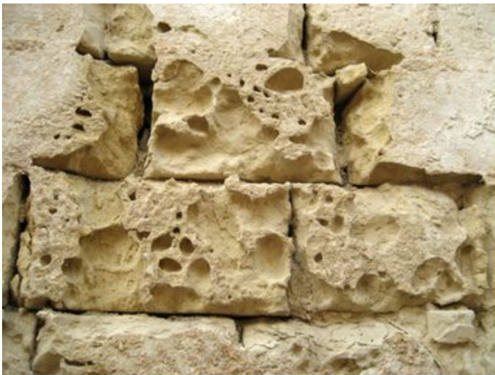
FOGAÇA, J.R.V. Por que a chuva ácida corrói os monumentos históricos? Mundo Educação . Disponível em: < https://mundoeducacao.bol.uol.com.br/quimica/por-que-chuva-acida-corroi-os-monumentos-historicos.htm >. Acesso em: 25 mar 2019.
